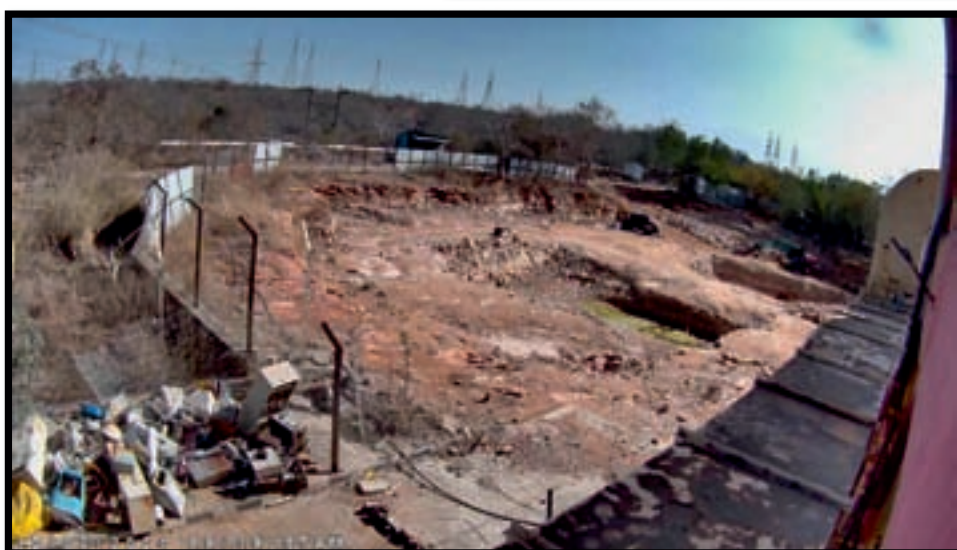
Fig. 8: ERF Excavation Site Photographs
